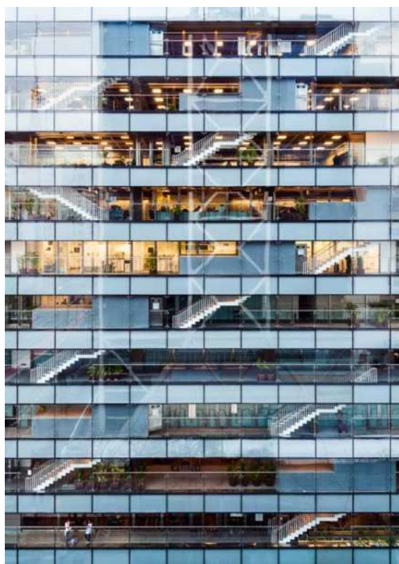
Fotografia 10 – Escadas junto a fachada
