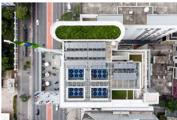
Fotografia 19 – Placas Solares na Cobertura
